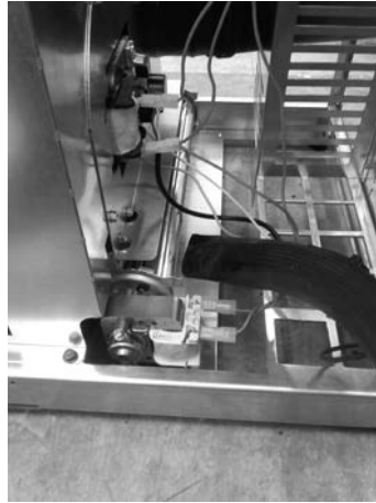
Fig. 35 - Καθαρισμός ανεμιστήρα δωματίου
